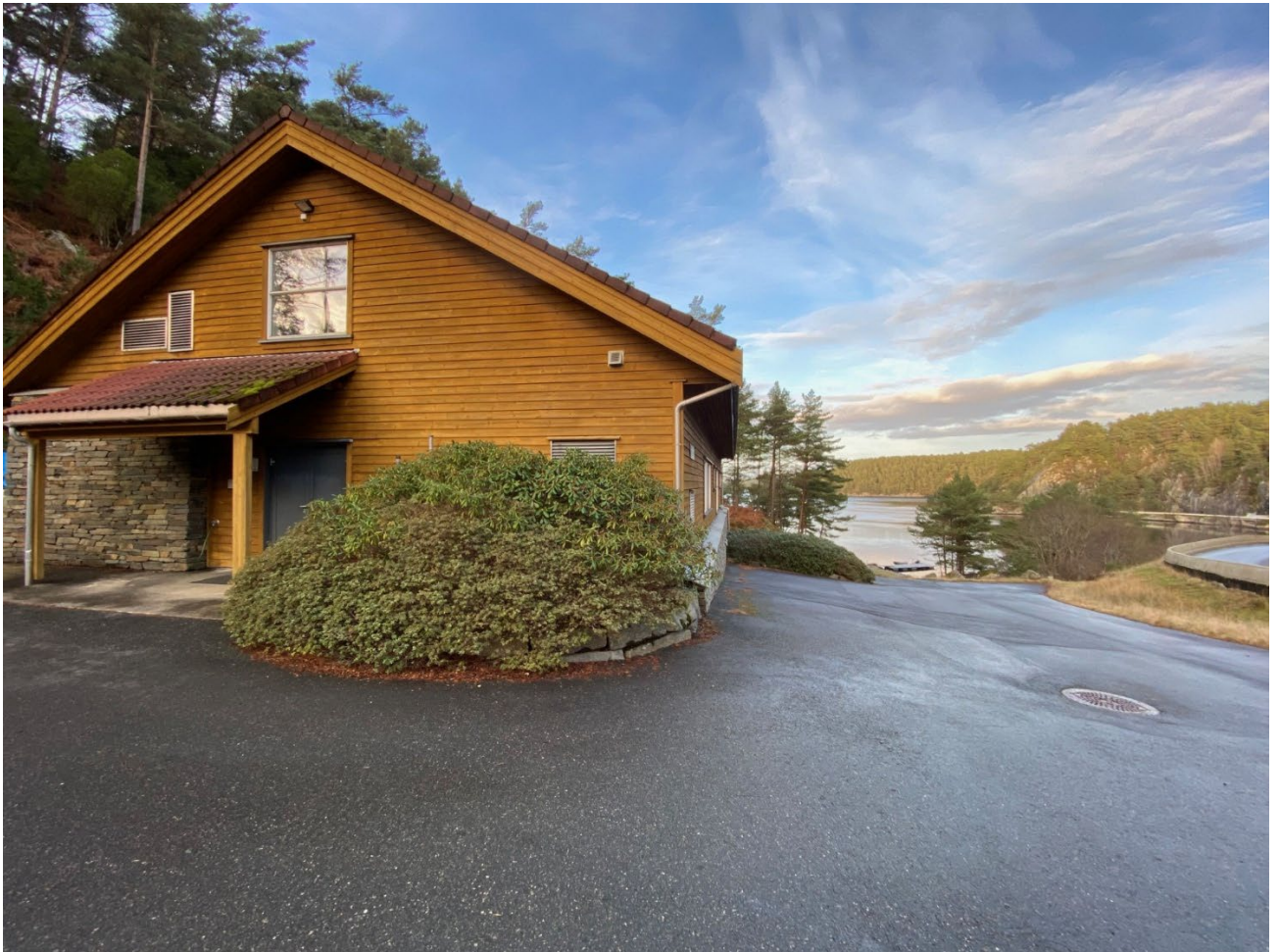
Vannbehandlingsanlegget i Kvednane
