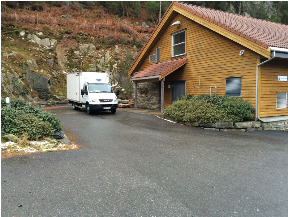
Figur 3: Vannbehandlingsanlegget i Kvednane
