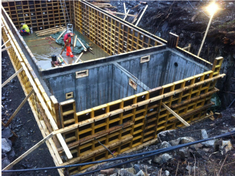
Figur 7: Frå etablering av felles slamavskiljar i Bekkjarvik 2014
