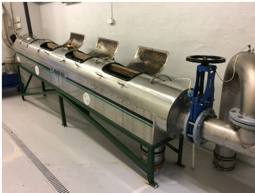
Figur 8: Avløpssil på Storebø
